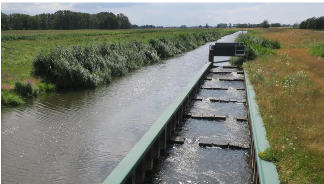
Fischtreppe am Wehr in Würdenhain
