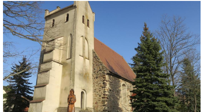
Holzschnitzfigur vor der Kirche in Oppelhain
